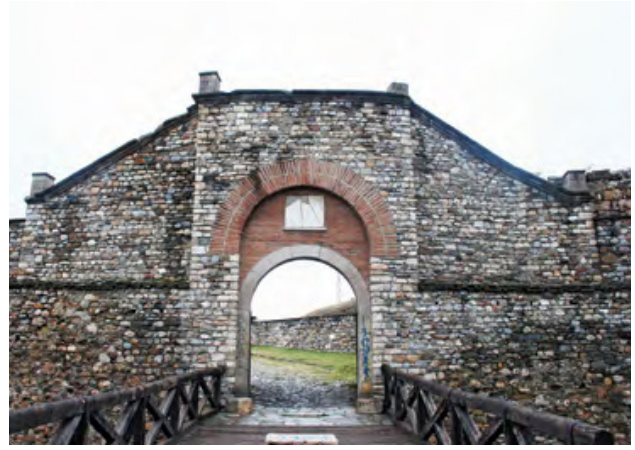
Сл. 15 Источна порта – реконструкција
